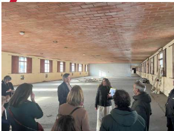
Bâtiment avant rénovation
