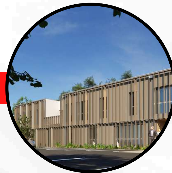
Construction d'une Usine relais sur un foncier gardé en réserve
