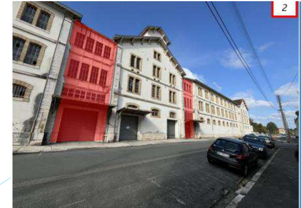
Passages traversants entièrement déconstruits
