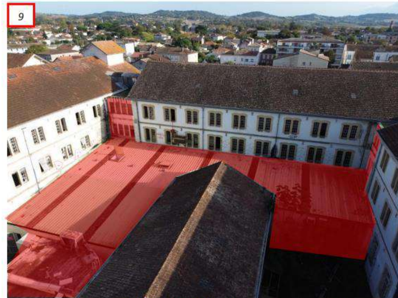
Déconstruction bâtiment K', Hexagones et extensions
