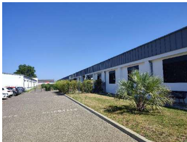
Bâtiment après rénovation
